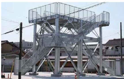
津波避難タワーの整備※1
