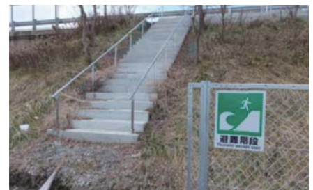
避難階段の整備※3
