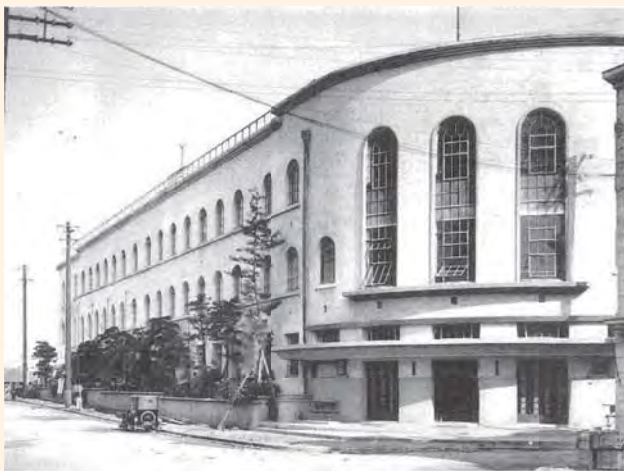
鉄筋コンクリート造の小学校(東京市立千代田小学校)
