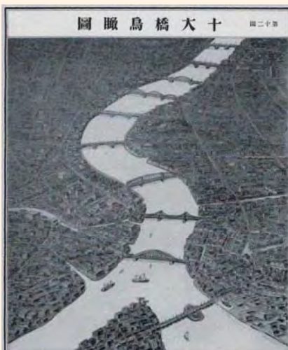
隅田川の橋梁
