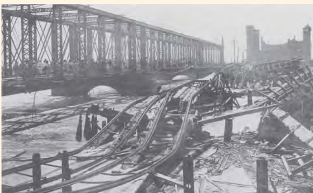
崩落した鉄橋（墨田・吾妻橋）
